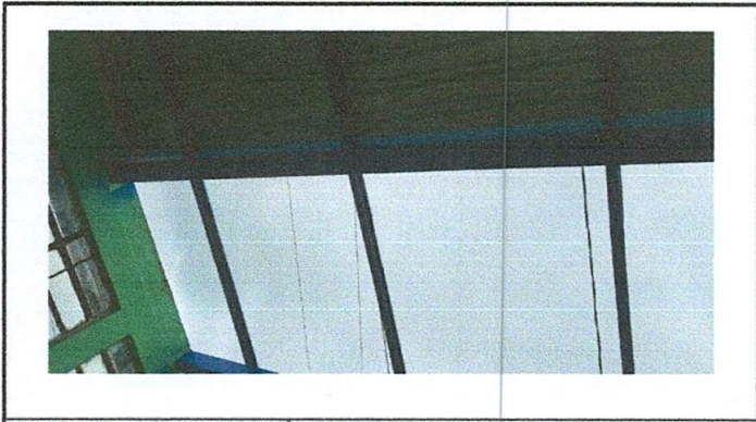
Foto1: COLOCACION DE LÁMINAS NUEVAS
